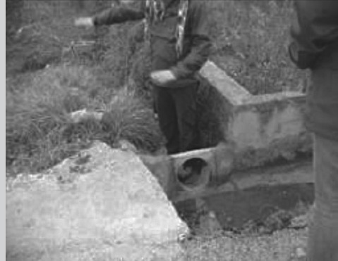
Figura 8. Através da aberturas, a água é desviada para as lavouras localizadas as margens das estradas vicinais. Fonte: foto dos autores (2009)
