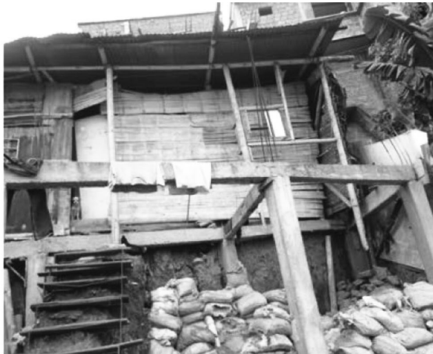
Figura 10. Viviendas construidas haciendo una mezcla de diferentes tipos de materiales como concreto, guadua y esterilla. Fuente propia, 2014.
