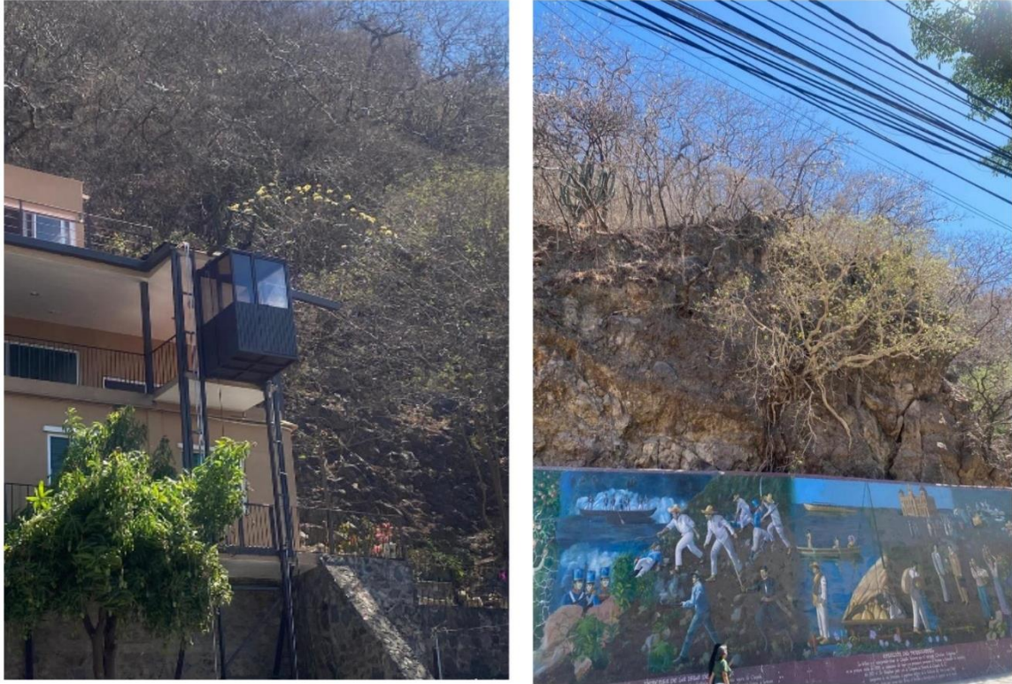
Figura 9. Edificaciones habitacionales y comerciales en áreas de riesgo geológico por deslave
