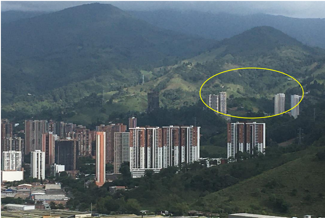
Figura 2. Costado sur oriental del municipio de Sabaneta
