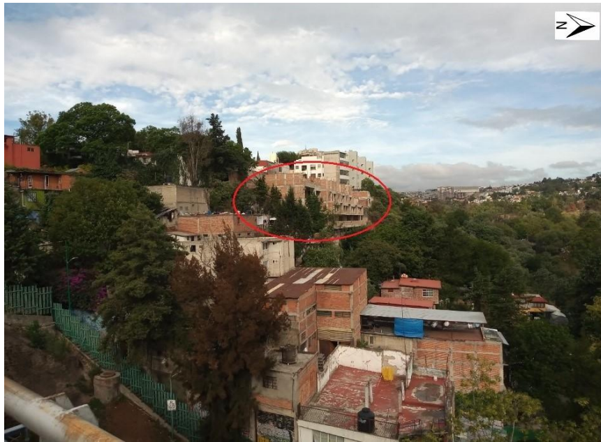
Figura 4. Fotografía área de estudio nueva construcción arquitectónica, Colonia Las Águilas
