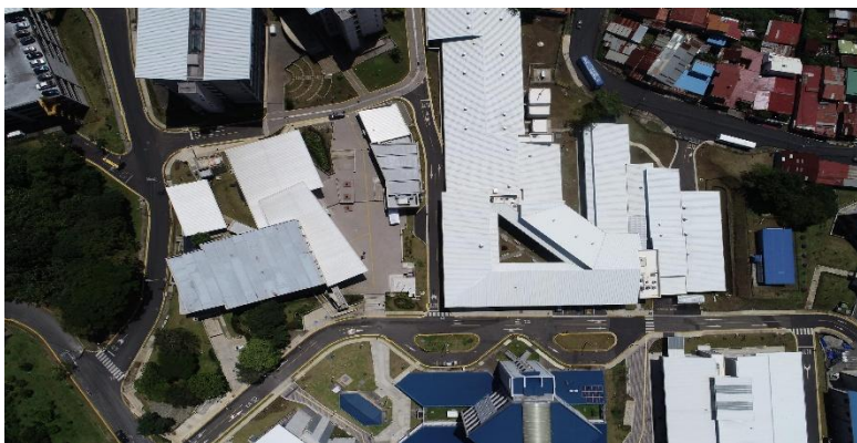
Figura 12. Nuevas edificaciones en finca 2.
